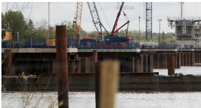
Photographie 1 : Exemple d'estacade - chantier LGV Bordeaux
